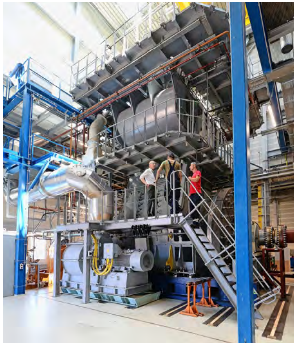
Um am 16 Meter hohen Schiffsmotor (grau) zu arbeiten, wurden Plattformen (blau und silbern) in der WinGD-Werkhalle gebaut. Foto: Marc Dahinden
